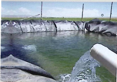
Almacenamiento de agua de pozo profundo para riego del cultivo
