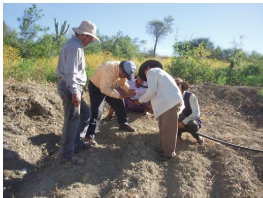
INSTALCIÓN DEL SISTEMA DE RIEGO POR GOTEO
